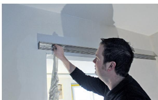
Schiene mit einem trockenem Tuch (z.B. Küchentuch) reinigen oder mit Druckluft ausblasen,
