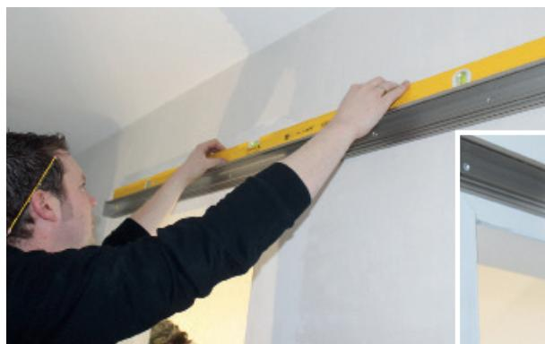
Schiene mit geeigneten Schrauben (5x70 bis 5x80mm) befestigen und Positionen überprüfen,
