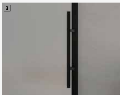
3 Für alle Türen und Festverglasungen werden aus schmalen, matt schwarzen Aluprofilen Umrahmungen für das Glas gebaut
