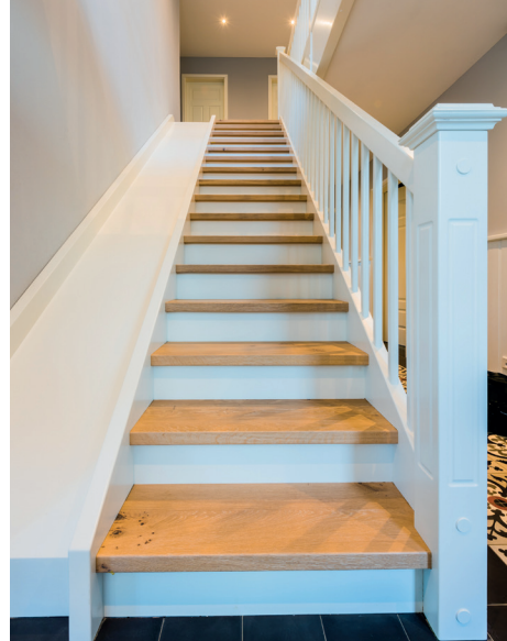
Massivholztreppe mit Geländer
